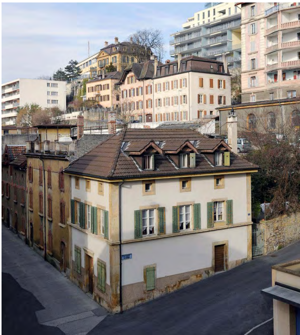
La maison de vigne du début du 19 e siècle, au numéro 3 de la rue Edmond-de-Reynier
